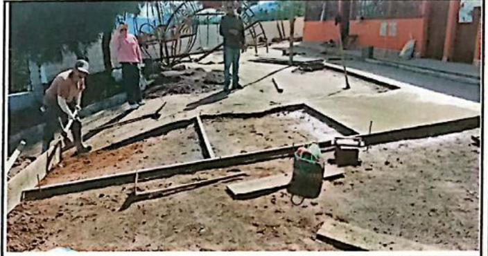
Foto 4: Reparación de piso de concreto
